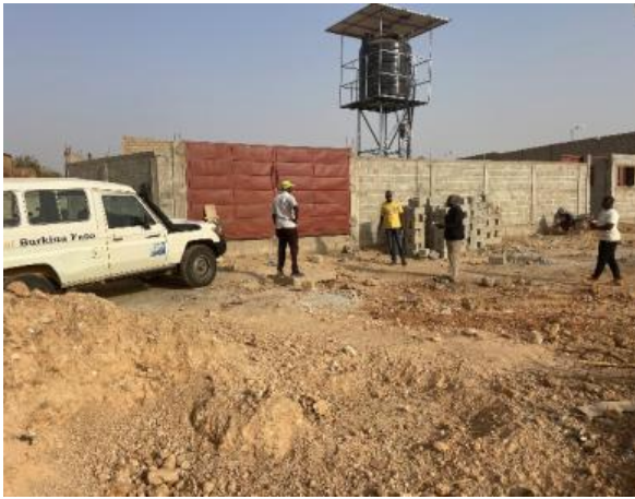
Construction du centre d'hébergement d'urgence avec soins infirmiers et psychologiques
